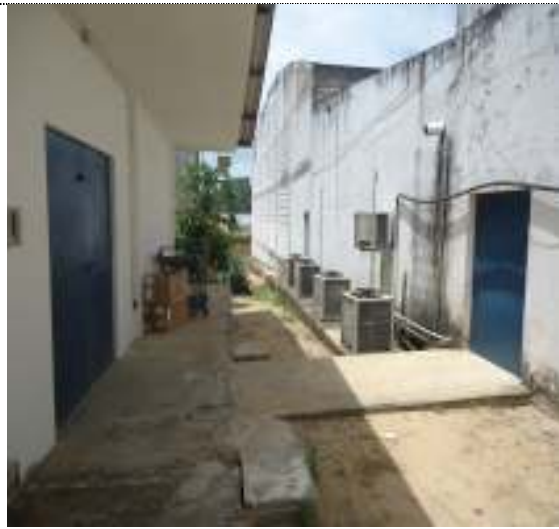
Foto 1 da entrada da sala principal para armazenagem de medicamentos CEAF na UNICAT em Natal (1ª quinzena de setembro de 2014)- Detalhe: passagem “ao tempo” para o prédio principal
